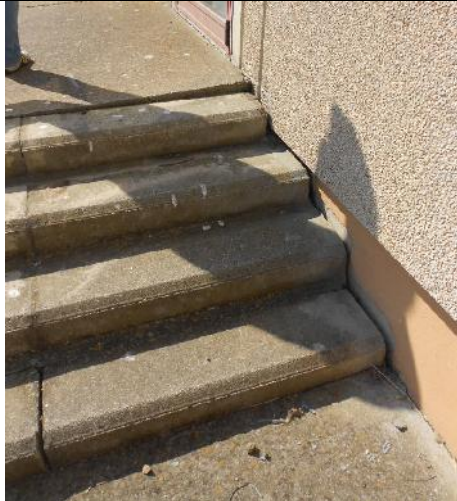
RIFACIMENTO SCALE E PARAPETTI
