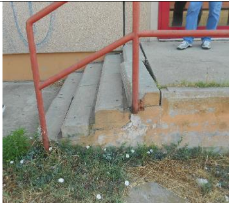
RIFACIMENTO SCALE E PARAPETTI
