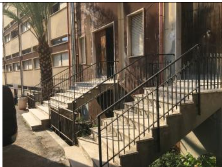
SCALE IN DEMOLIZIONE E RICOSTRUZIONE
