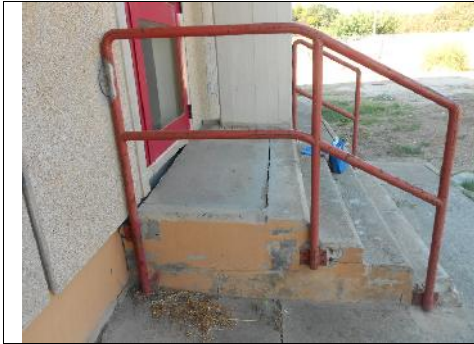
RIFACIMENTO SCALE E PARAPETTI
