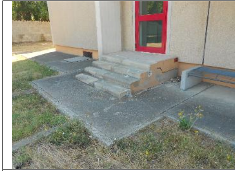
RIFACIMENTO SCALE E PARAPETTI
