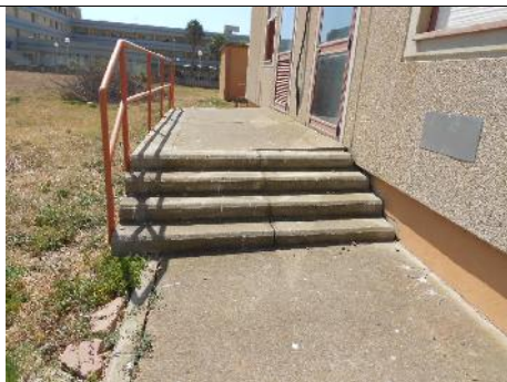
RIFACIMENTO SCALE E PARAPETTI
